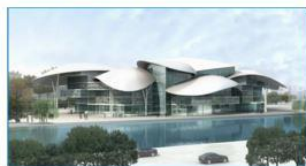
格鲁吉亚司法部大楼
